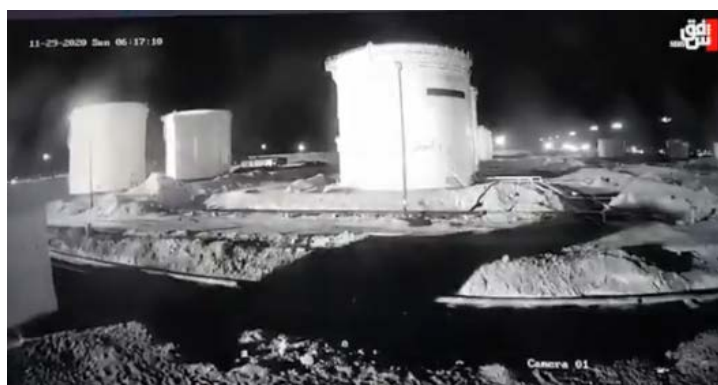
Réservoirs de pétrole et oléoducs de la raffinerie d'Al-Siniya avant d'être touchés par une roquette de l'Etat islamique (photo prise par des caméras de sécurité sur le site - Shafaq News, 30 novembre 2020)
