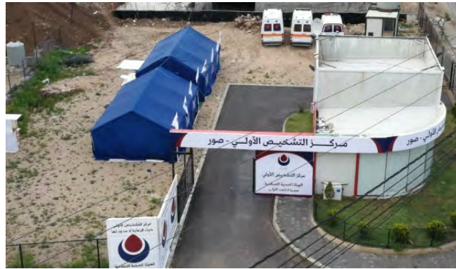
מרכז האבחון הראשוני של ארגון הבריאות האסלאמי בצור, לאחר השלמת הקמתו (אתר "ג'נוביה", 21 באפריל 2020)
