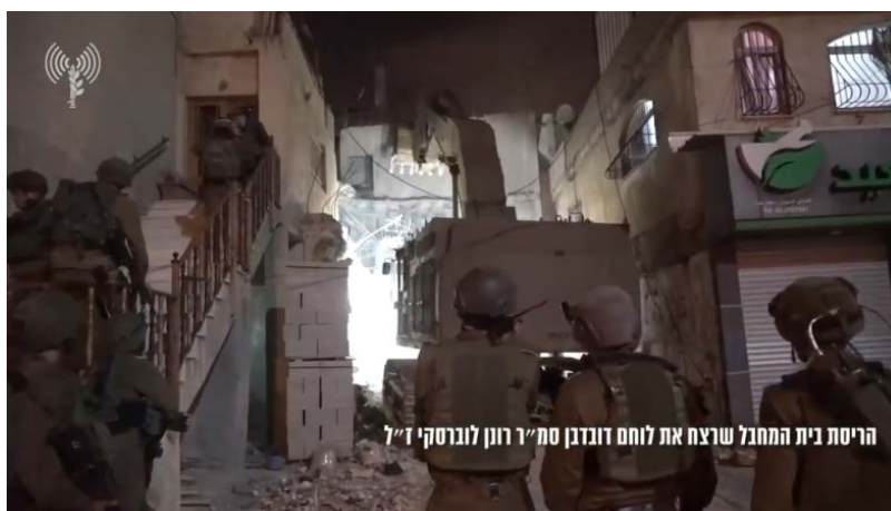
Démolition du domicile d'Islam Abu Hamid dans le camp de réfugiés Al-Ameri à Ramallah (Compte Twitter du porte-parole de Tsahal, 24 octobre 2019)
