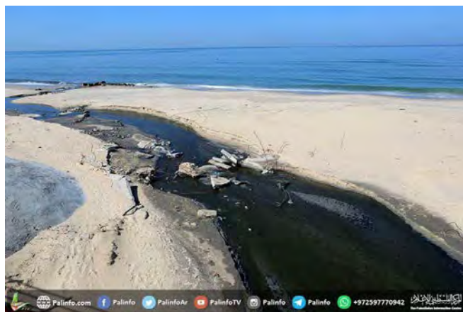
Déversement des eaux d'égouts dans la mer à cause du manque de combustible pour faire fonctionner les stations de pompage (Compte Twitter Palinfo, 11 mars 2018)
