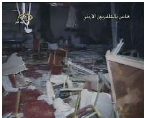
Разрушения в одной из гостиниц после теракта (источник: телевидение Иордании, 09.11.05)
