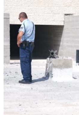
Toit d'un supermarché de Sderot atteint par une roquette le 4 mai (Hamutal Ben-Sheetrit, 4 mai 2008) www.sderotmedia.co.il
