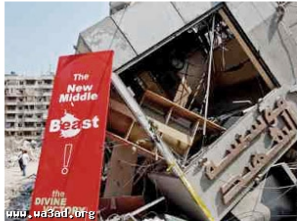
Débris du bâtiment de la Fondation Al-Shahid après un raid aérien de l'armée de l'air israélienne pendant la seconde guerre du Liban 4
