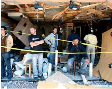
Ruines d'un café Internet de la bande de Gaza détruit en Avril 2007 (Dunia Al-Watan, 22 avril 2007).
