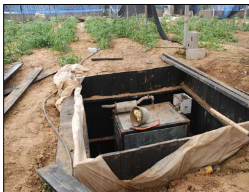
Генератор и инструменты для земляных работ, обнаруженные Армией Оборона Израиля в туннеле, вырытом возле теплицы на севере сектора Газа. Генератор был спрятан в земле, чтобы заглушить шум и затруднить его обнаружение (Интернет-сайт пресс-секретаря Армии Оборона Израиля 16 августа 2007 года).
