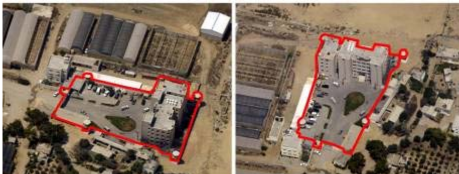
Zwei Aufnahmen des Hauptquartiers der Hamas Exekutive Force und der Izz al-Din al-Quassam Brigaden im nördlichen Gazastreifen. Die Hamas nahm das Gebäude im Juni 2007 ein. Dort befinden sich auch ein Waffen- und Warenlager. In der Operation "Gegossenes Blei" wurde es angegriffen. (IDF Sprecher, 27. Dezember
