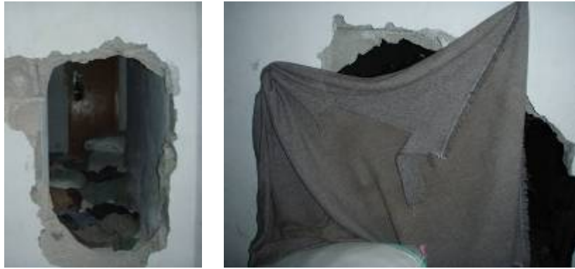
Durchbrochene Wände, um die Flucht zu ermöglichen.
