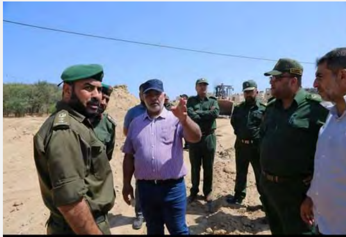
Der stellvertretende Innenminister im Gazastreifen, Tawfiq Abu Na'im, überwacht die Bauarbeiten (Facebook-Seite des Innenministeriums im Gazastreifen, 28. Juni 2017)
