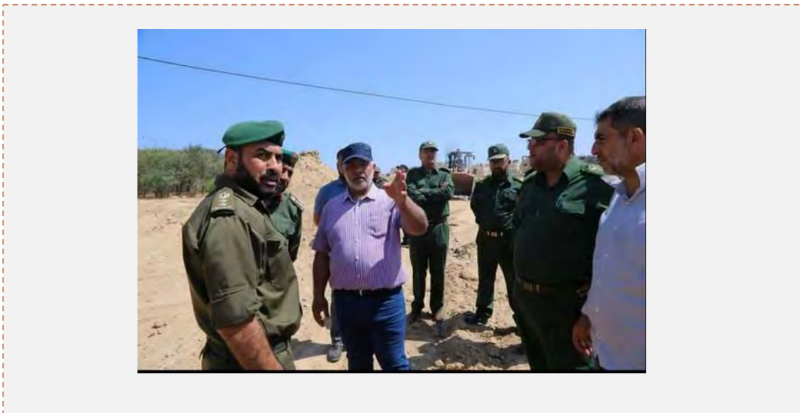
Tawfiq Abu Na'im, vice-ministre de l'Intérieur de la bande de Gaza, supervise les travaux de construction sur le terrain (Page Facebook du ministère de l'Intérieur de la bande de Gaza, 28 juin 2017)
