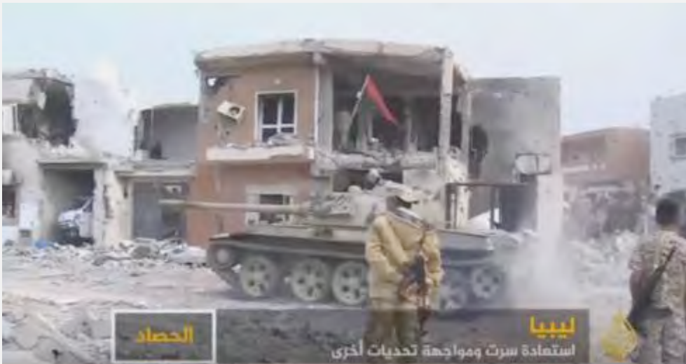
Dévastation autour de Syrte: la restauration des infrastructures devrait prendre de nombreuses années (Al-Jazeera, 12 décembre 2016)
