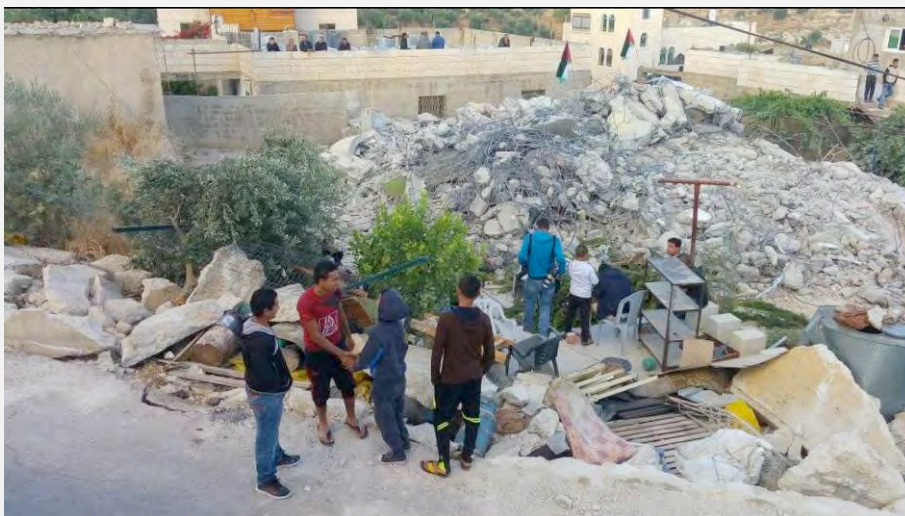
La maison de Murad Bader Abdallah Adais après la démolition par les forces de sécurité israéliennes (PNN, 11 juin 2016)
