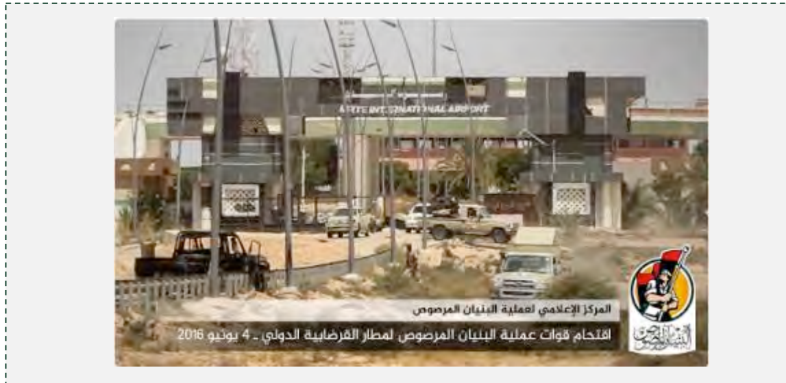
Entrée des forces dans l'aéroport international d'Al-Qardabiya (Compte Twitter du centre d'information de la campagne sur Syre, 4 juin 2016)
