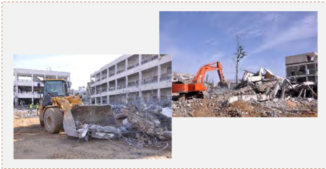
Evacuación de escombros de las casas del barrio Shaja'iyya en el marco del comienzo de los trabajos de rehabilitación del barrio (Filastin al Youm, 3 de diciembre de 2014)
