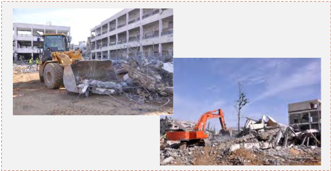
Die Trümmerräumung in Schadschaija im Rahmen der Sanierung des Stadtteils (Filastin al-Yawm, 3. Dezember 2014)
