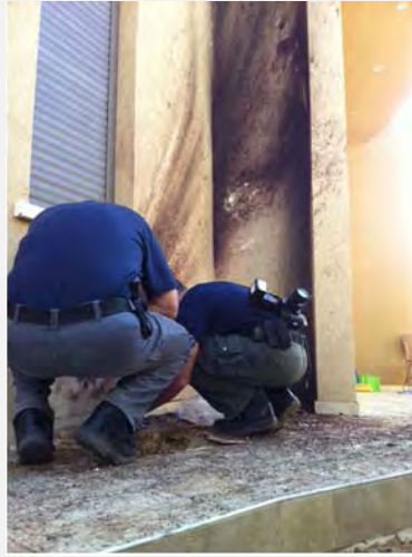
Démineurs de la police examinant les dégâts causés par la roquette à une maison de Sderot (Sderot media center, 21 mars 2013)
