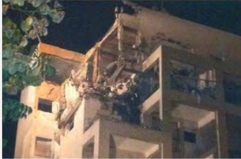
פגיעה קשה בבניין מגורים בראשון לציון כתוצאה מפגיעת רקטת פג"ר 5 (דף הפייסבוק של משטרת ישראל, 20 בנובמבר 2012)
