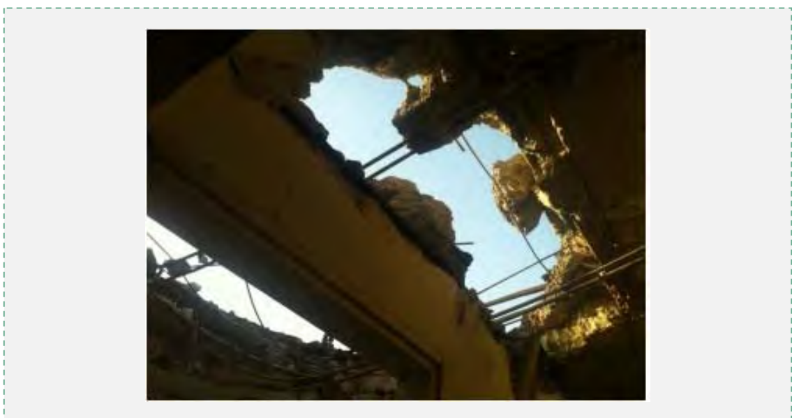
Ein zerstörtes Haus in Ofakim (Sderot Media Center, 17. November 2012).
