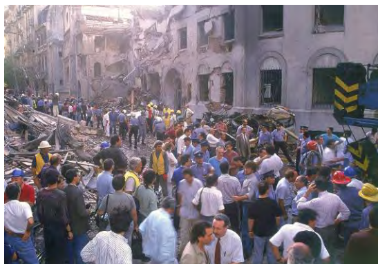
Edificio de la Embajada israelí tras la explosión
