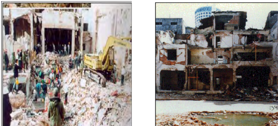
El edificio de la AMIA tras la explosión. Izquierda: Trabajos de rescate. Derecha: El hoyo que se abrió en la calle junto al frente del edificio. Se estima que la carga explosiva era de unos 400 kg.
