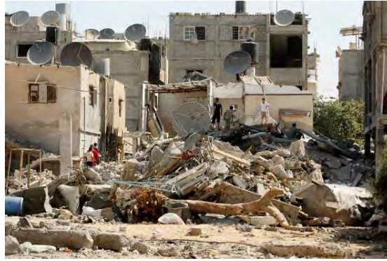
Les ruines de la maison du cheikh Abd al-Latif Musa à Rafah, détruite par le Hamas (Reuters, 16 août 2009). Le cheikh est mort à l'intérieur. Les bâtiments adjacents ont été endommagés.
